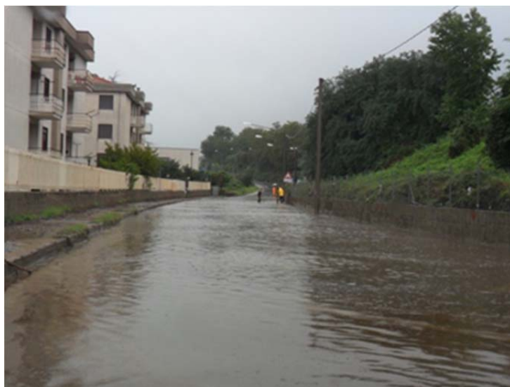
Allagamento Strada provinciale n.309 in corrispondenza della frazione di Sant'Angelo (Foto del 13.09.2012).
